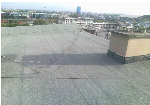
Technologia KETZ Laminat Mineral (renowacja papy, wykończenie posypką dekarą)
